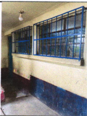
SUMINISTRO E INSTALACION DE BALCON DE METAL PARA VENTANA DE AULA
