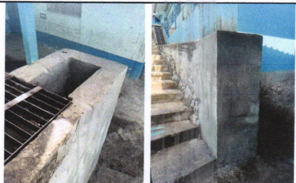
SUMINISTRO DE CAJA DE REGISTRO PARA AGUA PLUVIAL
