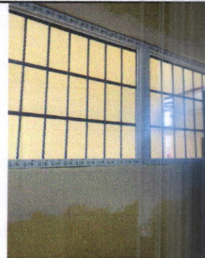
SUMINISTRO E INSTALACIÓN DE VENTANAS PVC CON BALCÓN EN AULA
