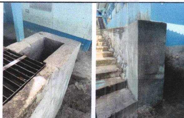
SUMINISTRO DE CAJA DE REGISTRO PARA AGUA PLUVIAL
