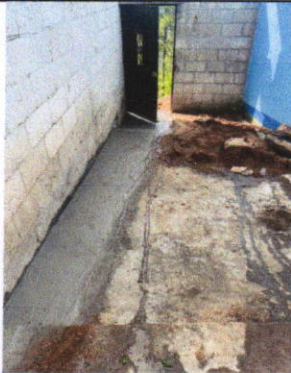
SUSTITUCIÓN DE TUBERÍA PVC DE DRENAJE PLUVIAL A 6"
