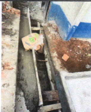
SUSTITUCIÓN DE TUBERÍA PVC DE DRENAJE PLUVIAL A 6"
