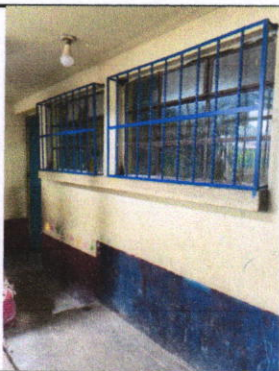
SUMINISTRO E INSTALACIÓN DE BALCÓN DE METAL PARA VENTANA DE AULA
