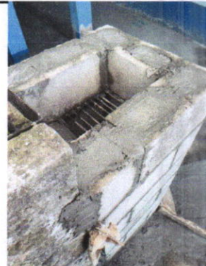
SUMINISTRO DE CAJA DE REGISTRO PARA AGUA PLUVIAL
