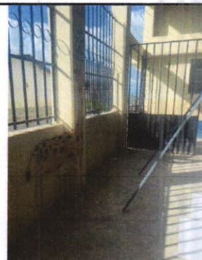
SUMINISTRO E INSTALACION DE REFUERZO A BALCON DE INGRESO
