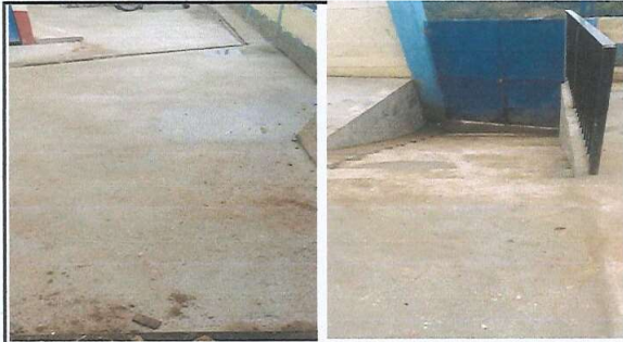
Foto 1: Reparación de piso de torta de concreto 10 cm Grosor (en el patio del establecimiento)
