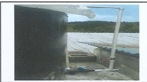
Foto 6: Sustitución de accesorios deposito de agua (cambio de posición del rotoplas del suelo hacia arriba)
