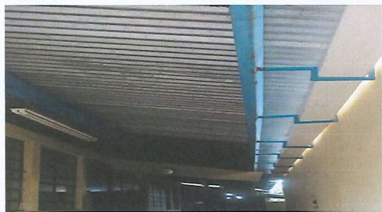
Foto 3: Sustitución de canal de pvc ( aulas de lamina del centro educativo)
