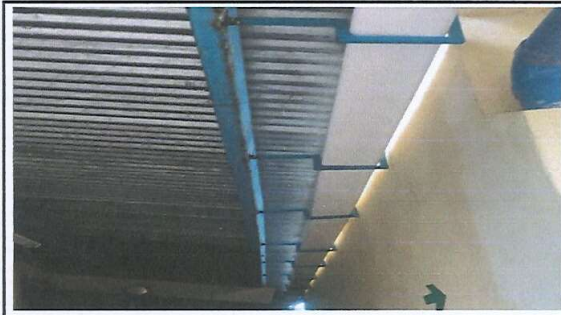
Foto 2: Sustitución de canal de pvc ( aulas de lamina del centro educativo)
