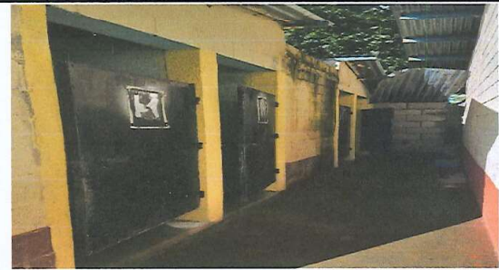
Foto 5: Sustitución de puertas de servicios apertura de 4 puertas de baños
