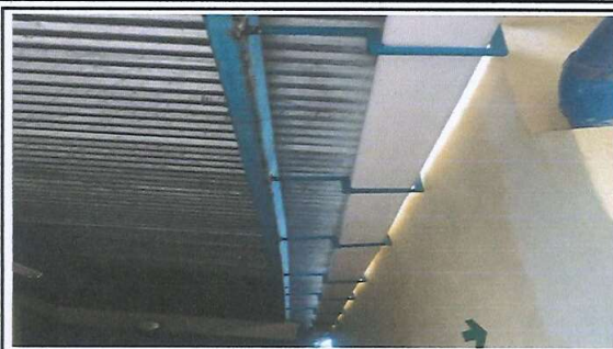
Foto 2: Sustitución de canal de pvc (aulas de lamina del centro educativo)
