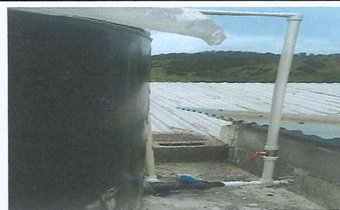
Foto 6: Sustitución de accesorios deposito de agua ( cambio de posición del rotoplas del suelo hacia arriba)
