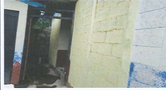
Foto 4: Sustitución de puertas de servicios sanitarios cierre de 4 puertas de baños
