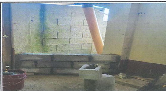
Foto 12: Reparación de muro perimetral de block.
