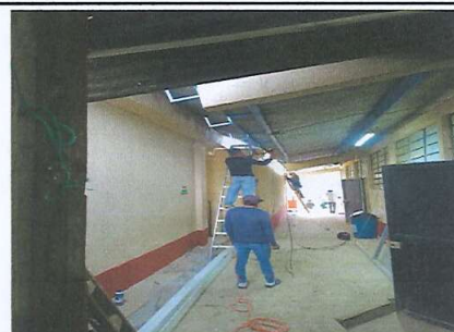
Foto 2: Sustitución de canal de pvc ( aulas de lamina del centro educativo)
