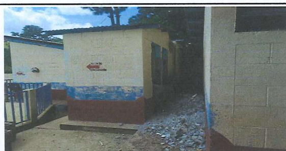
Foto 5: Sustitución de puertas de servicios apertura de 4 puertas de baños
