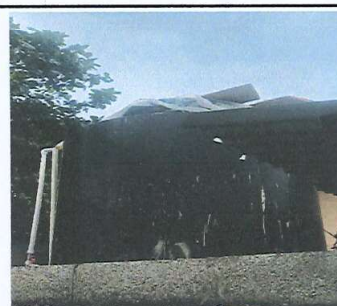
Foto 6: Sustitución de accesorios deposito de agua ( cambio de posición del rotoplas del suelo hacia arriba)
