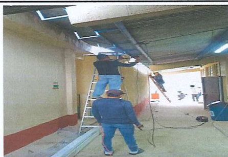
Foto 3: Sustitución de canal de pvc ( aulas de lamina delante del centro educativo)
