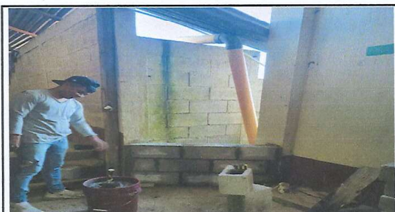
Foto 11: Reparación de muro perimetral de block.
