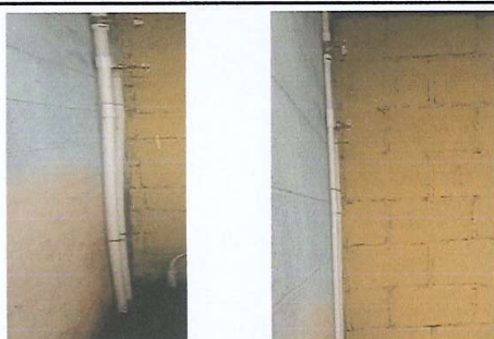
Foto 9: Sustitución de tubería pvc línea principal
