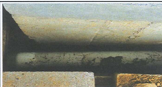
Foto 8: Sustitución de tubería pvc línea principal aguas negras
