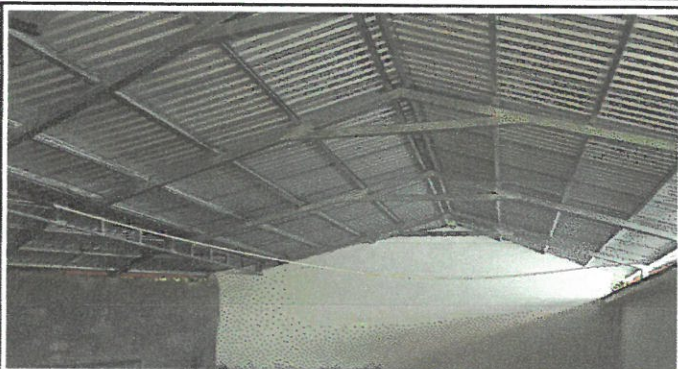
Techo remozado con estructura metálica y láminas troqueladas.
