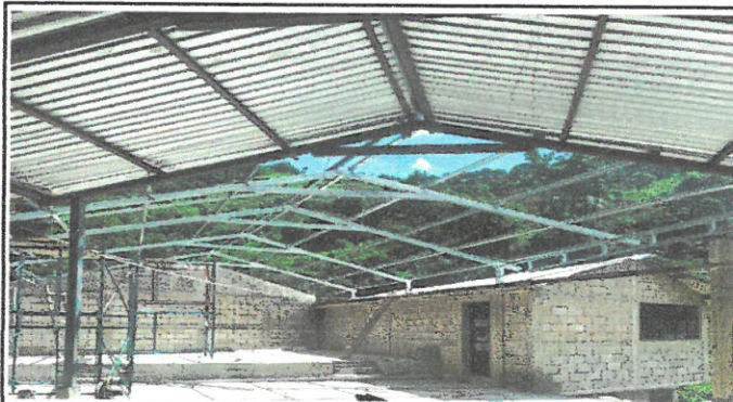
Entechado en proceso de mejorar con estructura metálica y láminas troqueladas.
