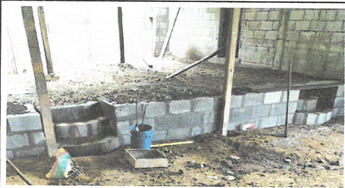
Remozamiento de muro de contención de escenario.
