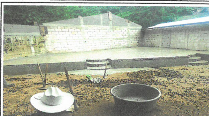
Fundición de patio y escenario con pavimento.
