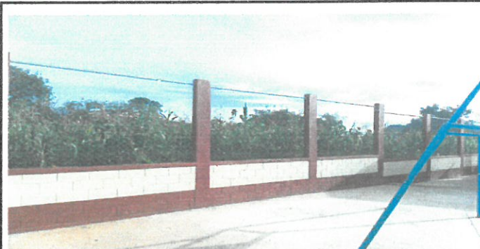
Foto 6: Área perimetral del Instituto Nacional de Educación Básica de Telesecundaria construida con block y malla.
