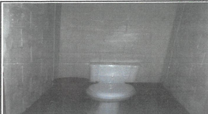
Foto 2: Instalación de inodoro en dos servicio sanitario, del Instituto Nacional de Educación Básica de Telesecundaria.
