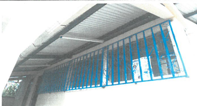
Foto 1: Ventana de aulas, balcones instalados de las aulas del Instituto Nacional de Educación Básica de Telesecundaria
