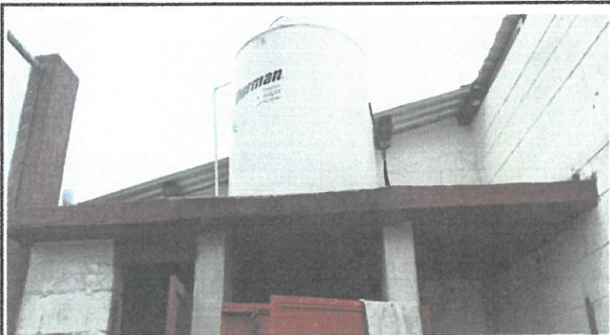
Foto 4: Construcción de techo de terraza de los servicios sanitarios, del Instituto Nacional de Educación Básica de Telesecundaria.
