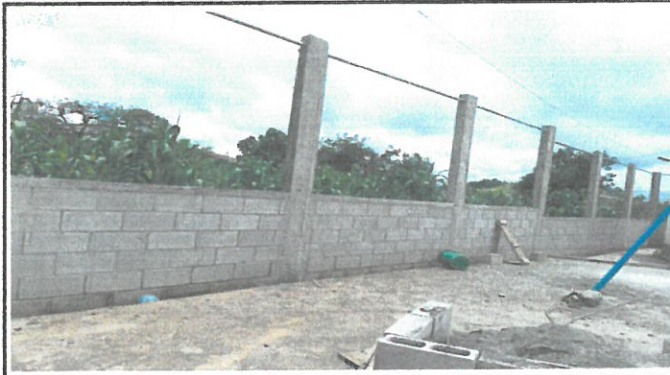
Foto 4: Construcción de muro perimetral de todo el perímetro superficial del Instituto Nacional de Educación Básica de Telesecundaria.
