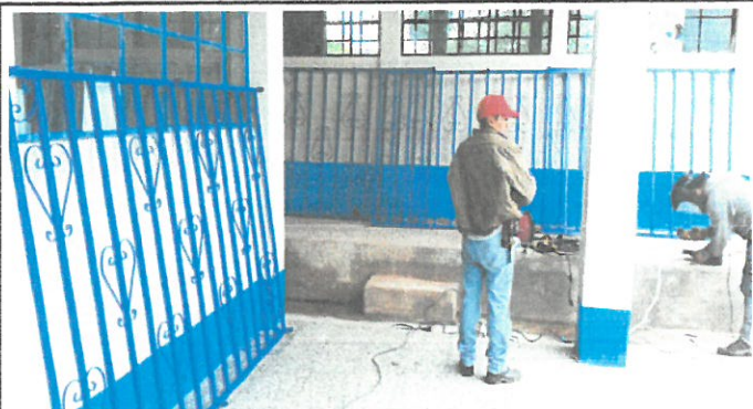
Foto1: Instalación de balcones en 3 aulas del Instituto Nacional de Educación Básica de Telesecundaria
