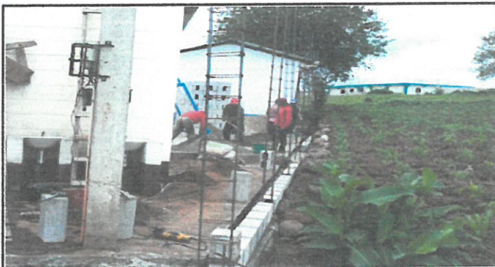
Foto 3: Instalació de columnas en muro perimetral del Instituto Nacional de Educación Básica de Telesecundaria
