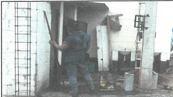
Foto 2: Instalación de puerta metal de baño, del Instituto Nacional de Educación Básica de Telesecundaria.
