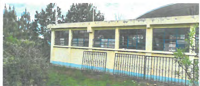
Sustitución de vidrios e instalación de balcones aulas 1 y 2, de tras
