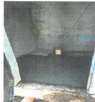
Sustitución de Inodoro baño 1
