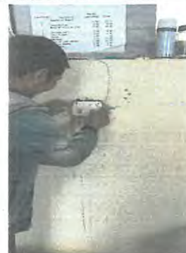
Instalación de tomacorrientes y cableado eléctrico
