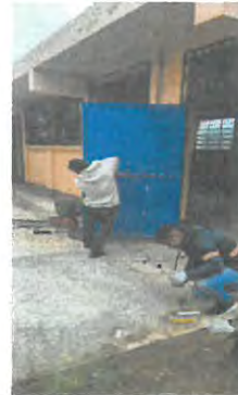
Sustitución de chapa, puerta aula 2
