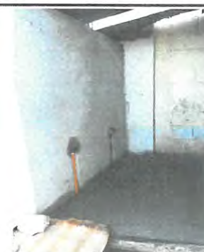
Instalación de mingitorio
