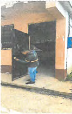
Sustitución de chapa, puerta aula 3
