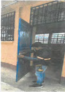
Sustitución de chapa, puerta aula 1
