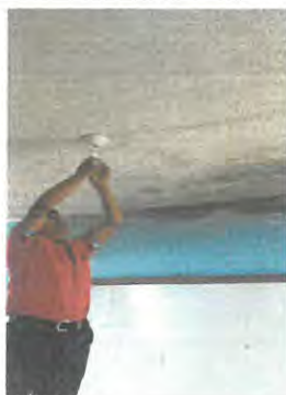
Sustitución de focos ahorradores y plafoneras
