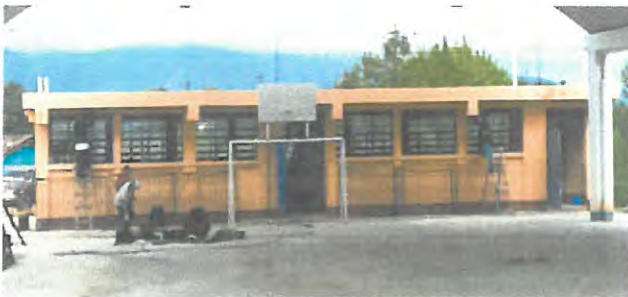
Sustitución de vidrios e instalación de balcones aulas 1 y 2, en frente
