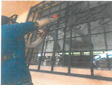
Sustitución de vidrios e instalación de balcones aula 3, en frente
