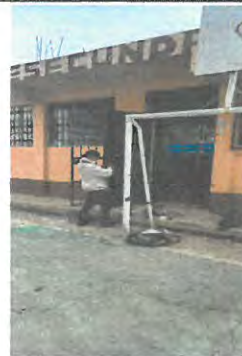
Sustitución de chapa, puerta aula 4
