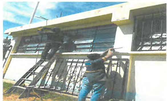
Sustitución de vidrios e instalación de balcones aula 3, de tras
