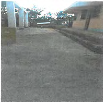
Reparación de banqueta
