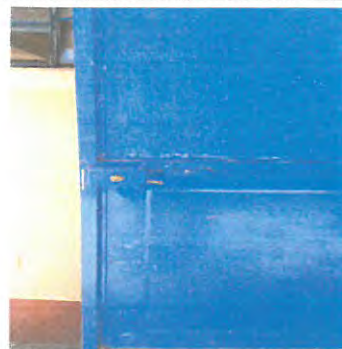
Sustitución de chapa, puerta aula 2
