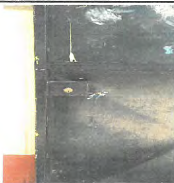
Sustitución de chapa, puerta aula 3
