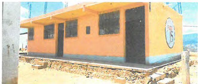
Reparación de banqueta
