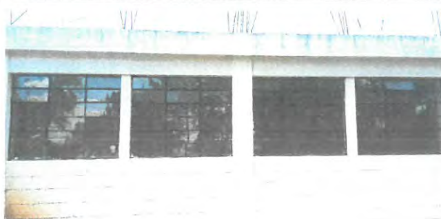
Sustitución de vidrios e instalación de balcones aula 3, de tras
