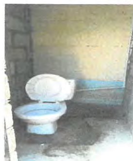
Sustitución de Inodoro baño 1
