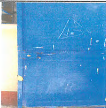
Sustitución de chapa, puerta aula 1
