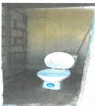
Sustitución de inodoro, baño 2
