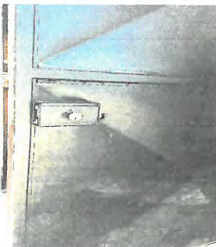
Sustitución de chapa, puerta aula 4
