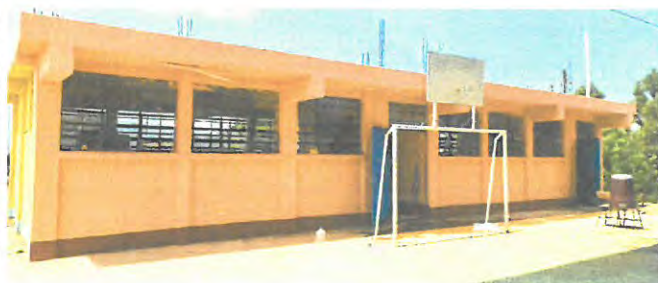
Sustitución de vidrios e instalación de balcones aulas 1 y 2, en frente
