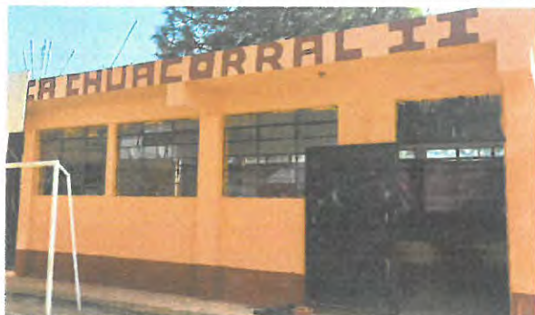
Sustitución de vidrios e instalación de balcones aula 3, en frente
