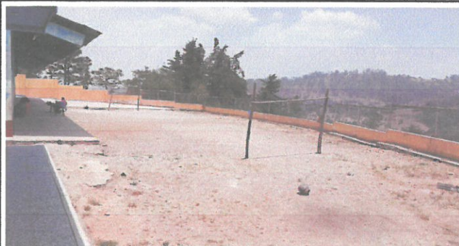
REGION DE TRABAJO 1. PAVIMENTACION DE PATIO EN ESTA FOTOGRAFIA PODEMOS OBSERVAR EL ANTES DE LA EJECUCION DEL QUINTO PROGRAMA
