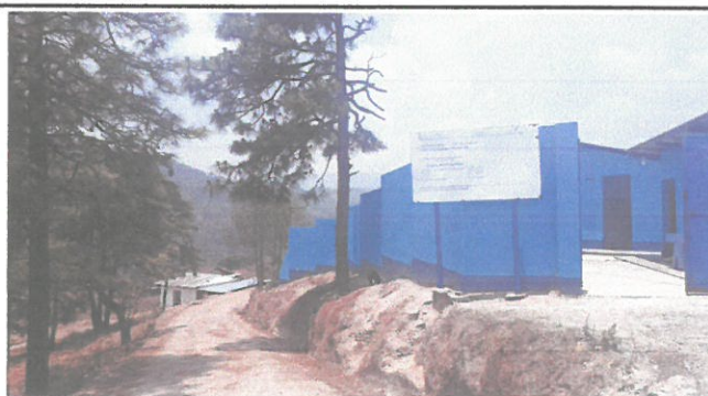
EN FOTOGRAFIA PODEMOS OBSERVAR LA CULMINACION DEL REGLON DE TRABAJO 2. DE PINTURA EN LA PARED PERIMETRAL DENTRO Y FUERA DEL ESTABLECIMIENTO.
