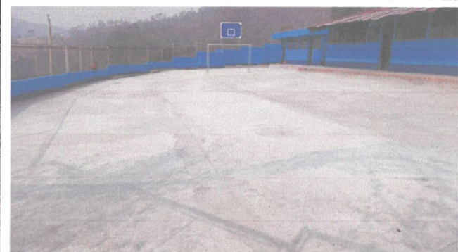
EN LA FOTOGRAFIA PODEMOS OBSERVAR LA CULMINACION DE LA PAVIMENTACION DEL PATIO .
