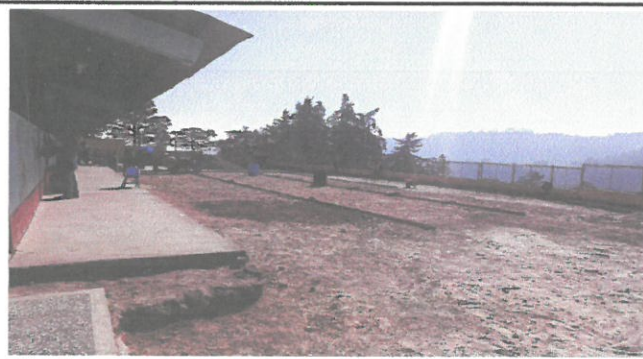
EN ESTA FOTOGRAFIA PODEMOS OBSERVAR EL DURANTE EN LA PAVIMENTACION DEL PATIO
