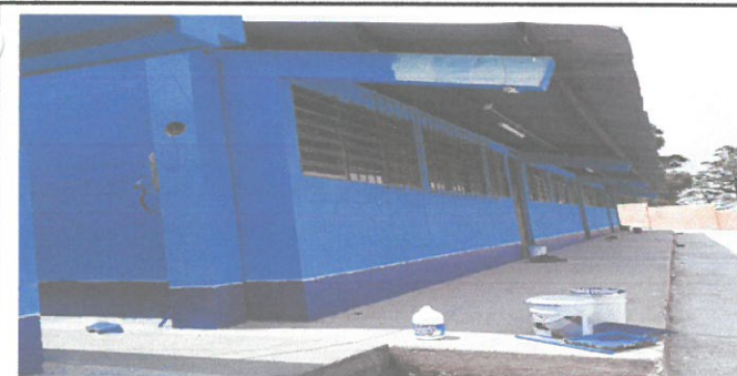
EN ESTA FOTOGRAFIA PODEMOS OBSERVAR EL DURANTE DE LA EJECUCION DEL REGLON DE TRABAJO DE PINTURA.
