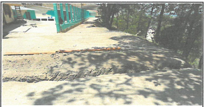
Foto 6: Pavimentación de patio frente de la cosina.
