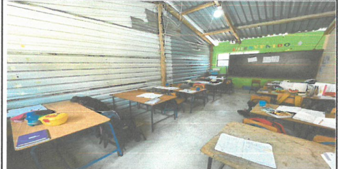
Foto 4: Reparación de la pared y cambio de piso de cemento a piso granito.
