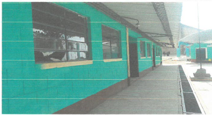
Foto 3: Colocación de balcones en cuatro aulas.
