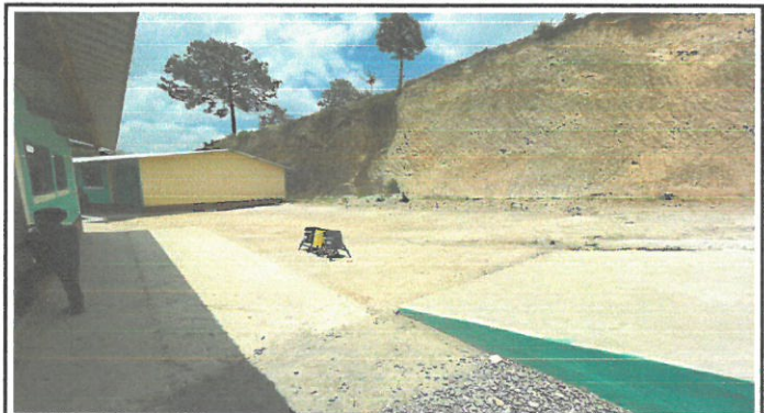
Foto 2: Pavimentación de patio del módulo 3.
