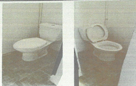
Foto 2: VISTA INTERNO DE LOS BAÑOS LAVABLES.
