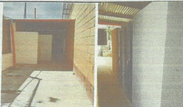
Foto1: VISTA EXTERNA DE LOS BAÑOS LAVABLES REMOZADOS.
