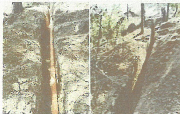
Foto 4: TUBERIA DE DRENAJE INSTALADO.
