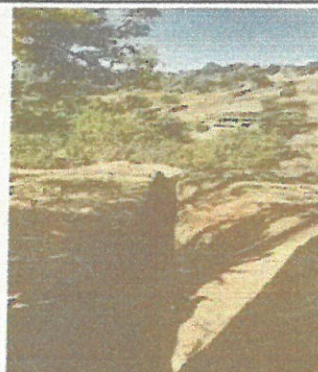
Foto 4: SANJEO AREA DE TUBERIA DE DRENAJE.
