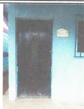
Area de sustitucion de puerta nueva cocina.
