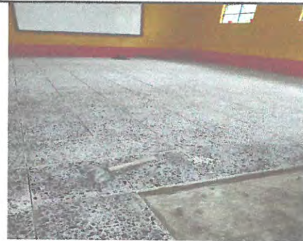
Area donde se instalara piso granito salon 1
