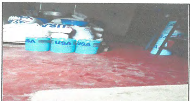
Area donde se instalara piso granito bodega
