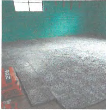
Area donde se instalara piso granito direccion.
