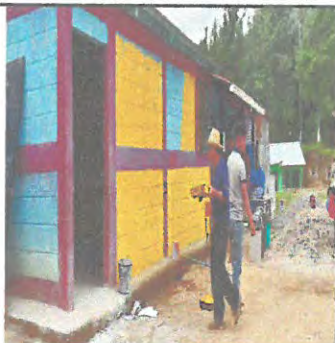
Area de sustitucion de puerta nueva salon 3.
