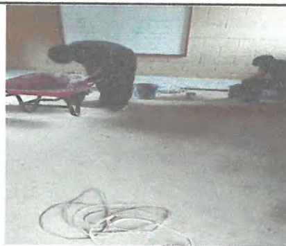
Area donde se instalara piso granito salon 3
