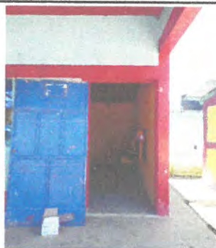
Area de sustitucion de puerta nueva salon 2.
