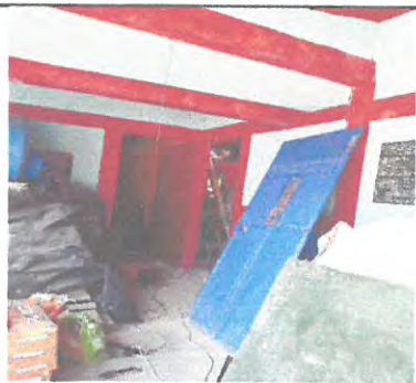
Area de sustitucion de puerta nueva biblioteca.
