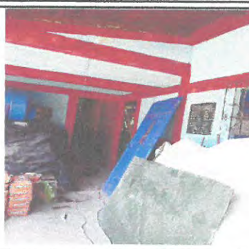
Area de sustitucion de puerta nueva direccion.
