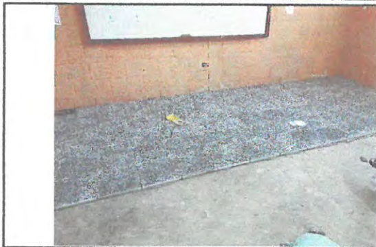
Area donde se instalara piso granito biblioteca
