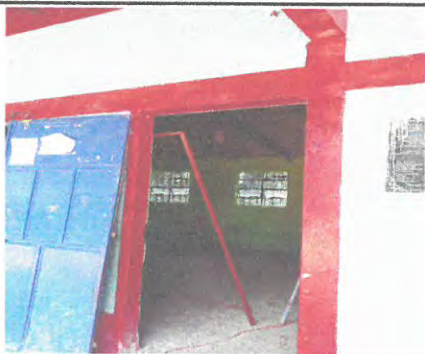
Area de sustitucion de puerta nueva salon 1.
