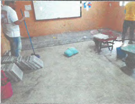
Area donde se instalara piso granito salon 2
