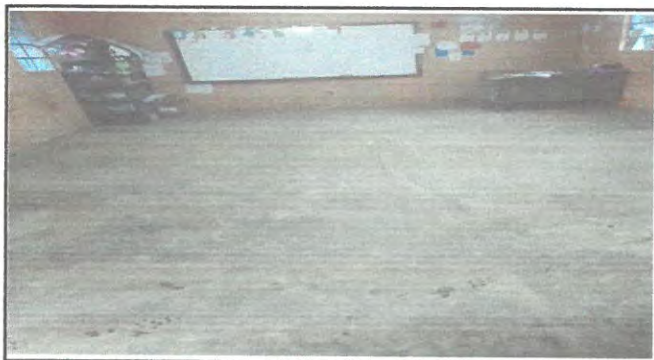
Area donde se instalara piso granito salon 2
