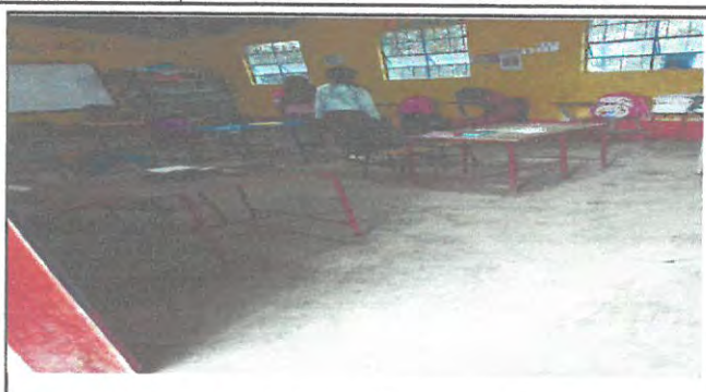
Area donde se instalara piso granito salon 1
