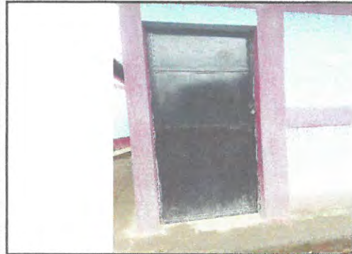
Area de sustitucion de puerta nueva salon 3.
