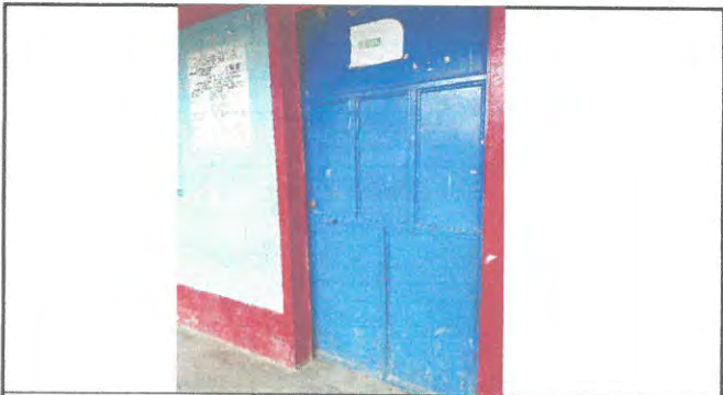
Area de sustitucion de puerta nueva salon 1.
