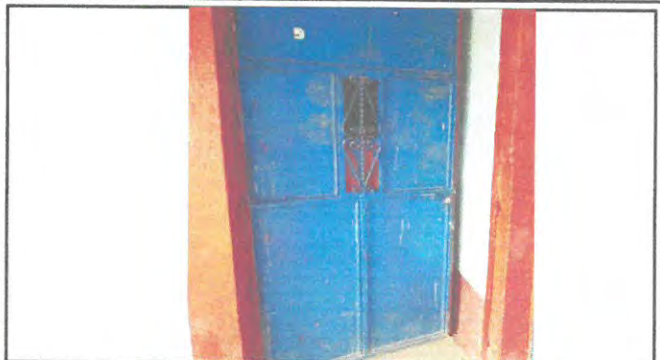
Area de sustitucion de puerta nueva direccion.
