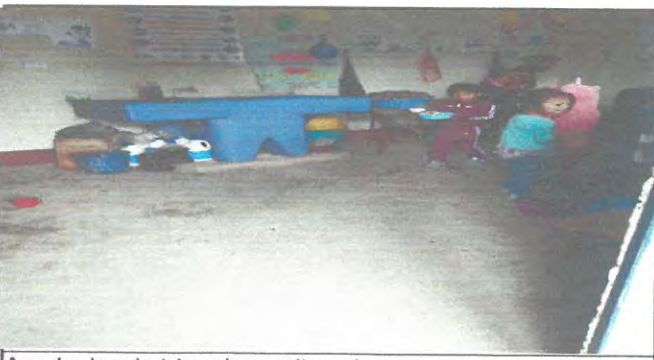
Area donde se instalara piso granito cocina
