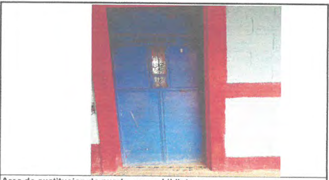
Area de sustitucion de puerta nueva biblioteca.
