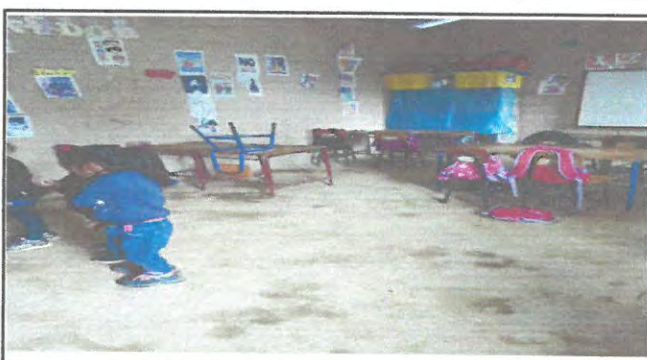
Area donde se instalara piso granito salon 3
