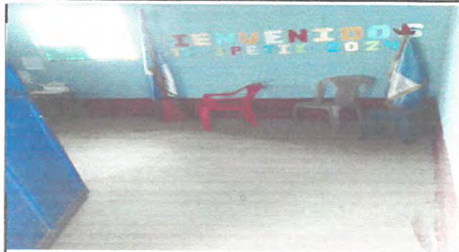
Area donde se instalara piso granito direccion.
