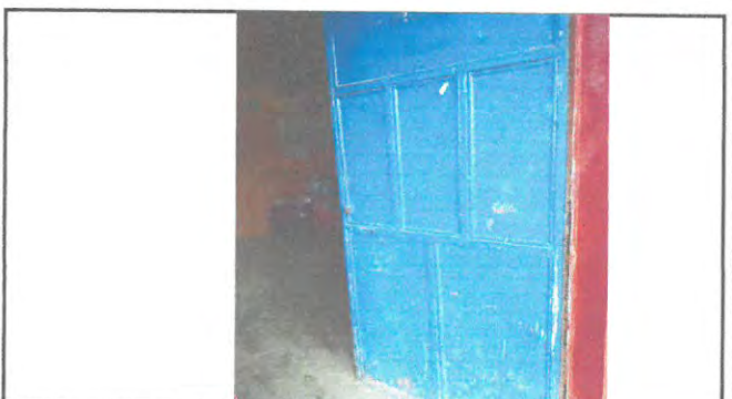
Area de sustitucion de puerta nueva salon 2.
