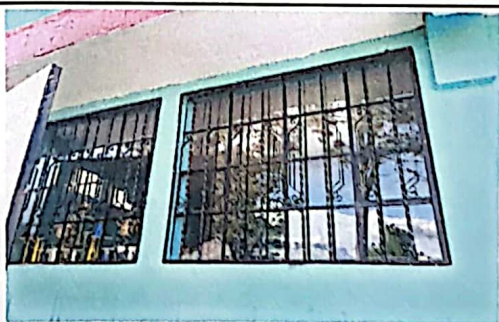
Balcones y ventanas colocadas
