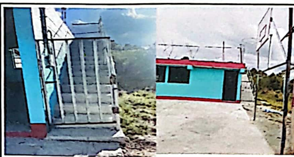
Sustitución de gradas de madera por gradas de concreto
