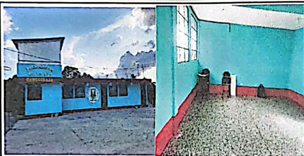
Aplicación de pintura de exterior e interior y logotipo
