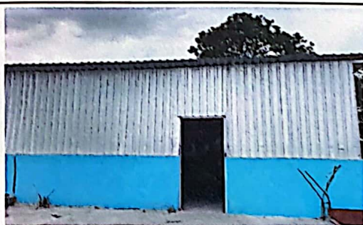
Placa de lámina sustituida por bloques y láminas troqueladas
