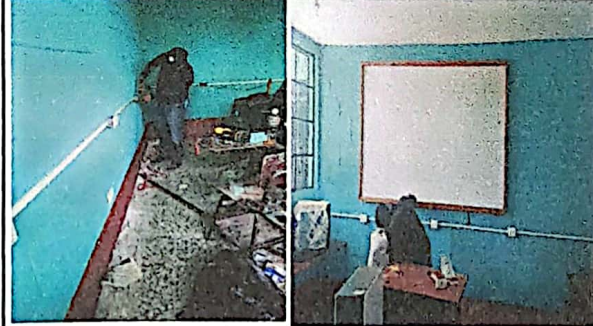
Instalación de energía eléctrica
