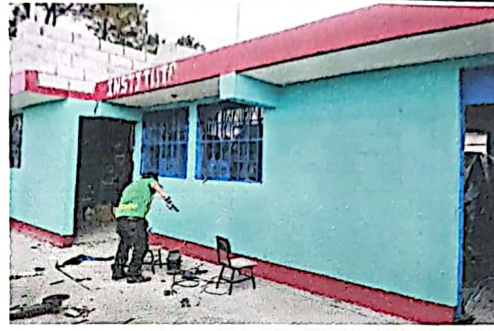
Colocación de las puertas
