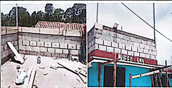
sustitución de galera de cocina de manina por block y lamina troquelada
