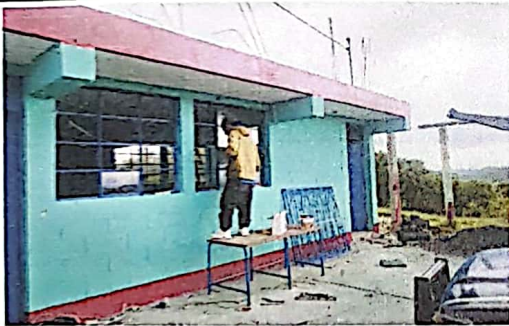
colocación de ventanas y balcones
