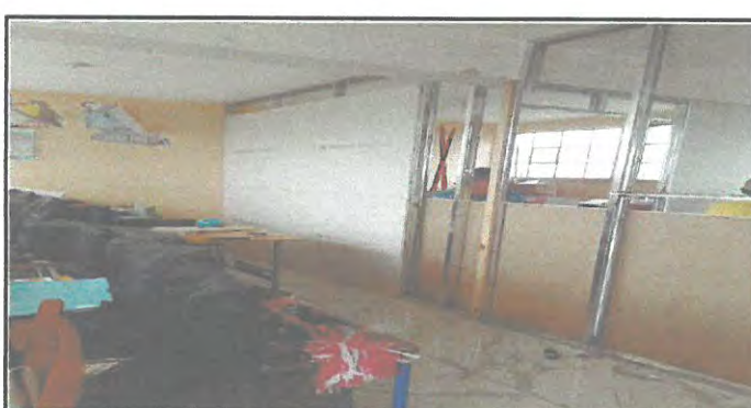
Foto 12: sustitución de pared prefabricado 2
