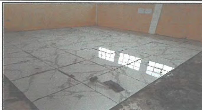
Foto 2: sustitucion de piso del segundo nivel.
