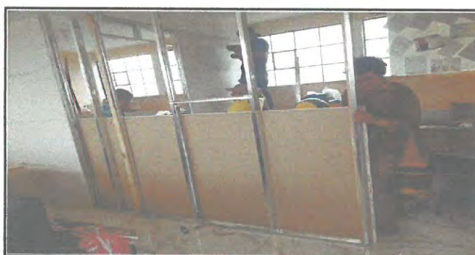
Foto 11: sustitución de pared prefabricado 1
