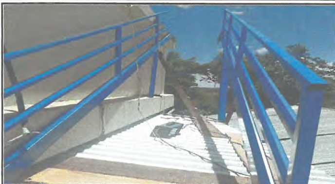
Foto 13: Instalacion de escalera 2do a 3er nivel 1
