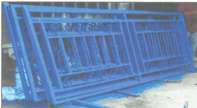
Foto 3: Instalación de balcón primer nivel.
