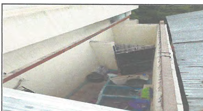
Foto 10: sustitución de techo sanitario
