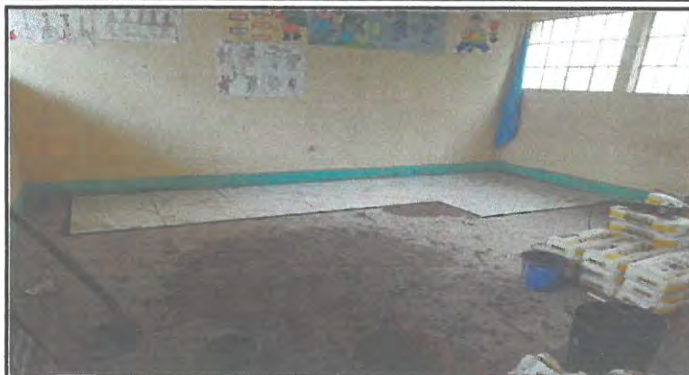
Foto 1: sustitucion de piso del primer nivel
