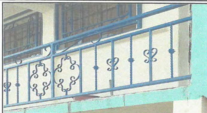
Foto 7: sustitución de baranda 1
