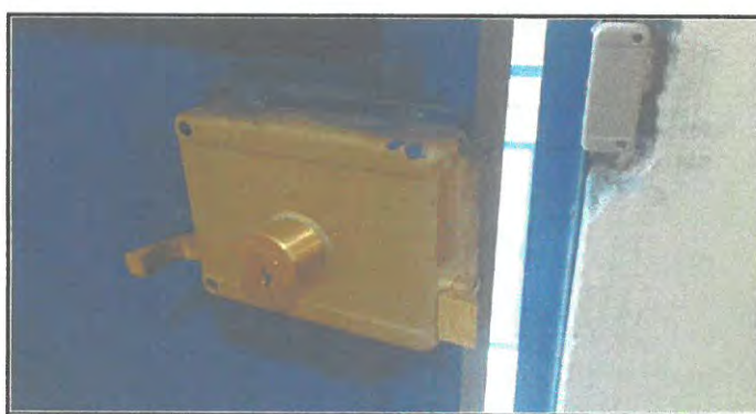
foto 6: cambio de chapas de las puerta de las aulas del establecimiento.
