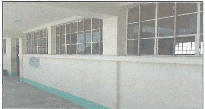
Foto 4: Instalación de balcón segundo nivel.
