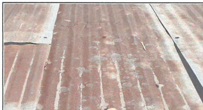
Foto 10: sustitucion de techo sanitario
