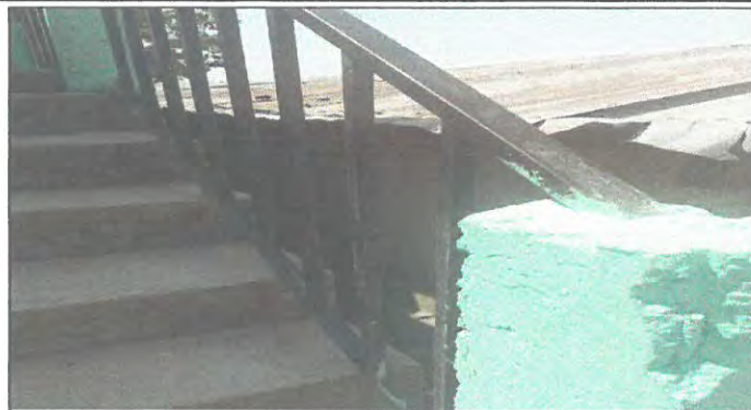
Foto 8: sustitucion de baranda 2
