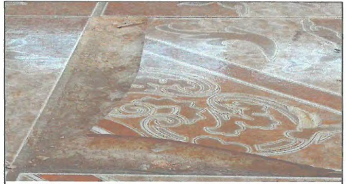
Foto 2: sustitucion de piso del segundo nivel.
