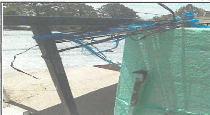
Foto 7: sustitucion de baranda 1
