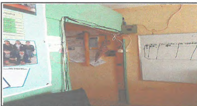
Foto 11: sustitucion de pared prefabricado 1
