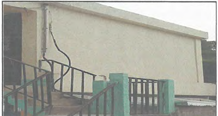
Foto 14: Instalacion de escalera 2do a 3er nivel 2
