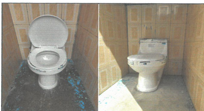
Foto 4: Sustrucción de baños sanitarios, sustitución de tubería de drenaje de baños.
