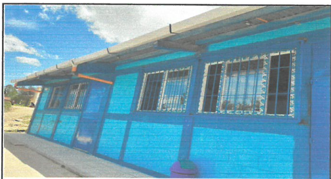
Foto 9: Sustitución de ventanas e instalación de balcones
