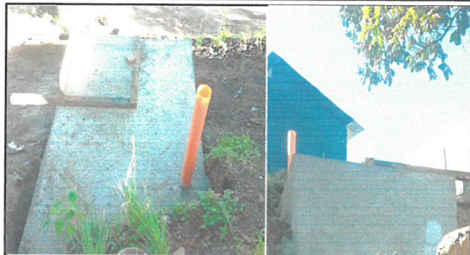
Foto 7: Sustitución de fosa séptica
