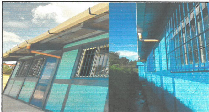
Foto 1: Sustrucción de canal de agua pluvial con sus respectivas bajadas.
