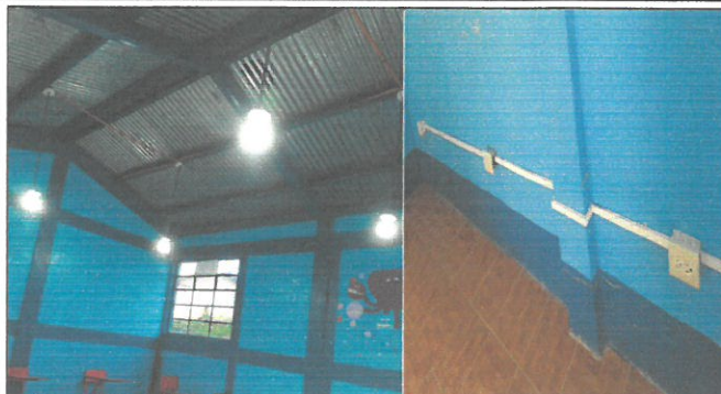
Foto 2: Sustrucción de: plafoneras, focos, apagadores, tomacorrientes y canaletas de electricidad.
