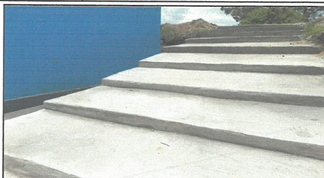
Foto 8: Fundición de gradas salida a carretera principal.
