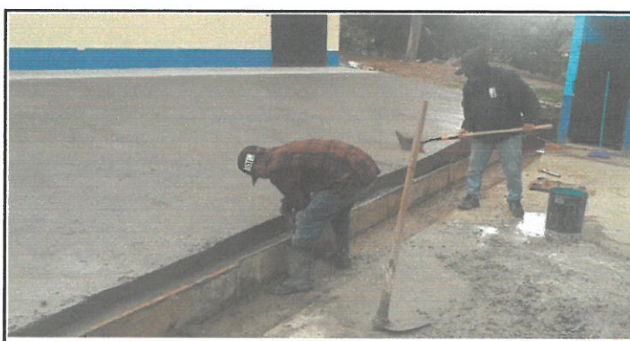
Foto 6: Pavimento de patio
