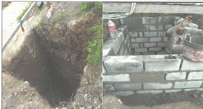
Foto 7: Sustitución de fosa séptica
