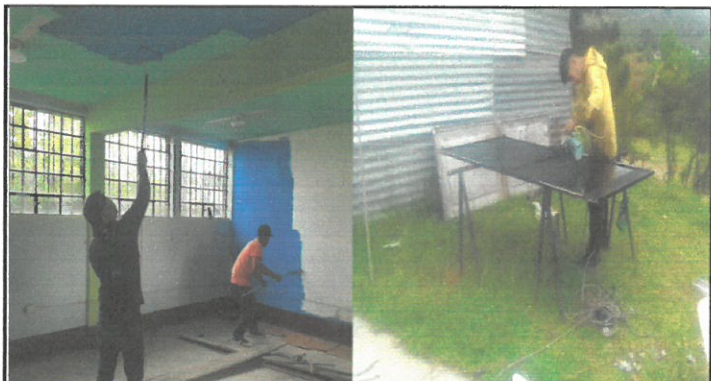
Foto 3: Pintura del laboratorio de computación, vidrieras, balcones y puertas.
