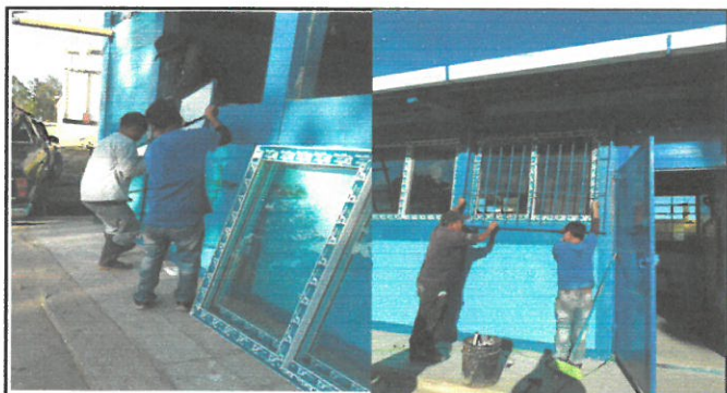
Foto 9: Sustitución de ventanas e instalación de balcones
