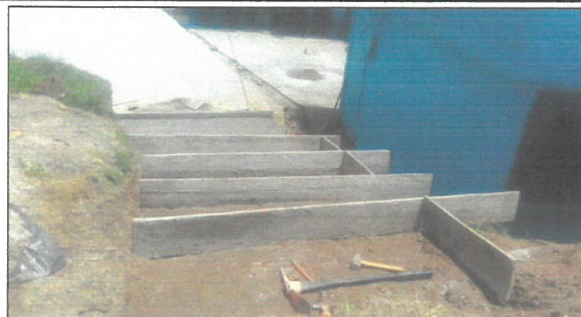
Foto 8: Fundición de gradas salida a carretera principal.
