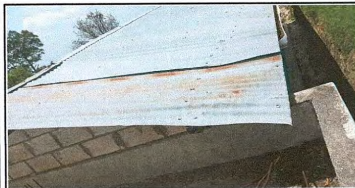
Foto 11: Sustitución de láminas del techo de la bodega.
