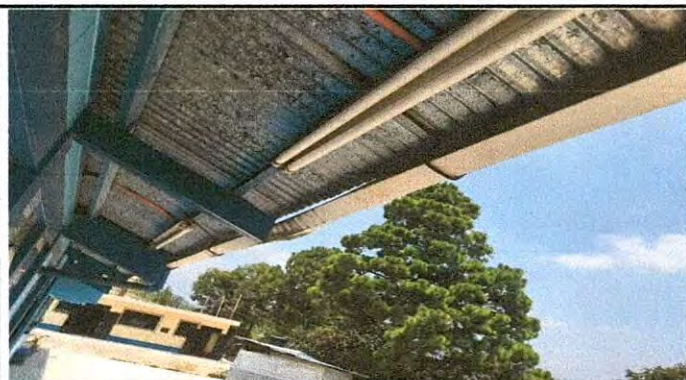
Foto 1: Sustitución de canal de agua pluvial con sus respectivas bajadas.
