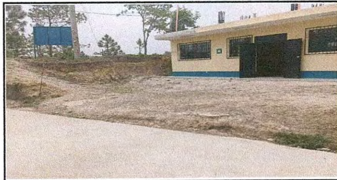
Foto 6: Pavimento de patio
