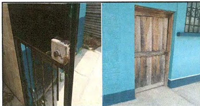
Foto 5: Reparación de puertas de baño, Sustitución de chapa de reja y sustitución de puerta de bodega.
