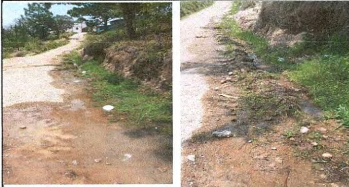
Foto 7: Sustitución de fosa séptica
