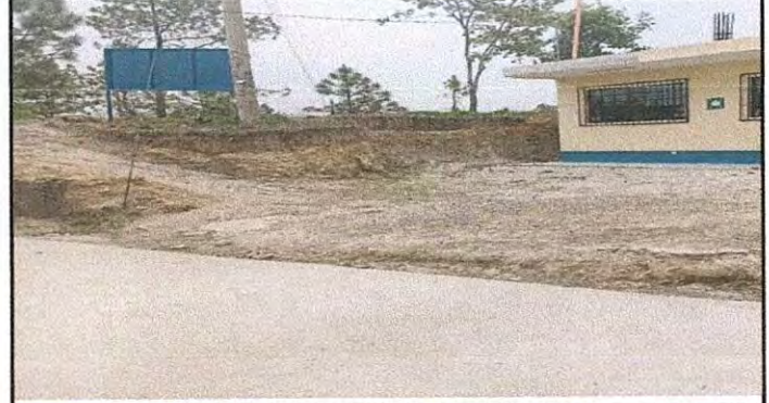
Foto 8: Fundición de gradas salida a carretera principal.
