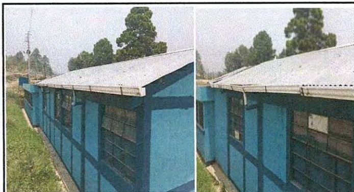
Foto 9: Sustitución de ventanas e instalación de balcones
