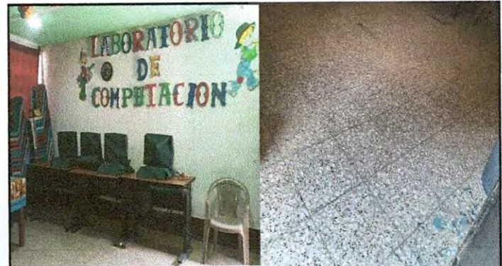
Foto 10: Sustitución de piso en el laboratorio.
