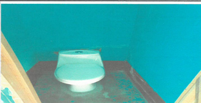
Foto 5: baños nuevos TRABAJO FINALIZADO CON EXITOS
