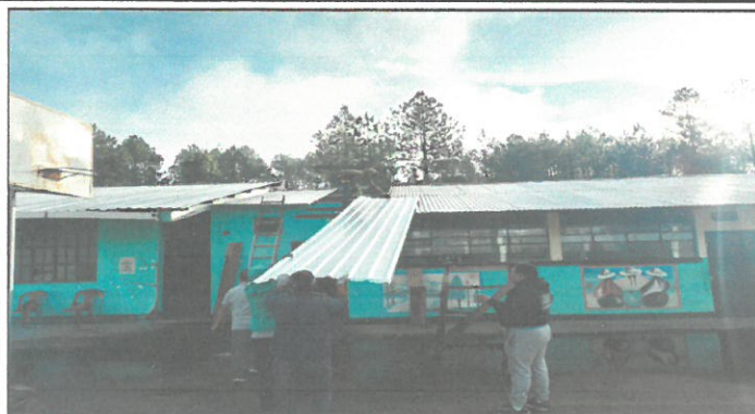
Foto 1: TECHADO: Cambio de láminas canalada por láminas troqueladas sobre las 3 aulas.
