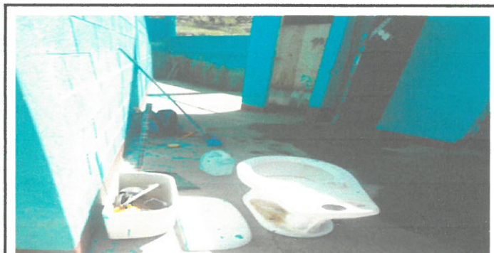
Foto 5: Cambio de los 4 baños por nuevas.
