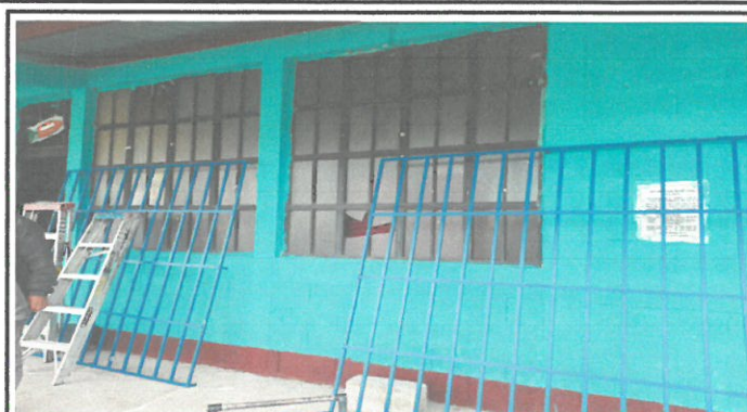
Foto 2: BALCONES DE LAS AULAS: Colocación de balcones en la ventanas de las 3 aulas de enfrente
