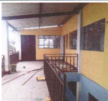
Foto 3: Pintura de paredes en el segundo nivel del NUFED 201 Aldea Santa Ana
