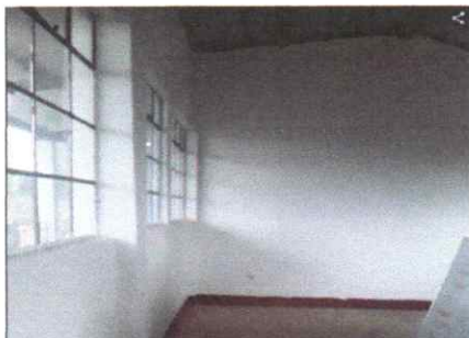
Foto1: Pintado de paredes, el primer aula segundo nivel
