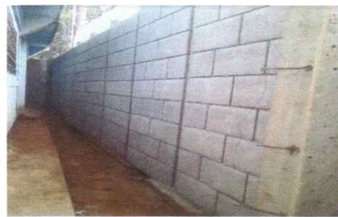
Foto 4: Muro perimetral en construcción ubicado al costado del NUFED 201
