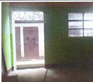
Foto 5: Apertura de la puerta para el pasillo de Dirección
