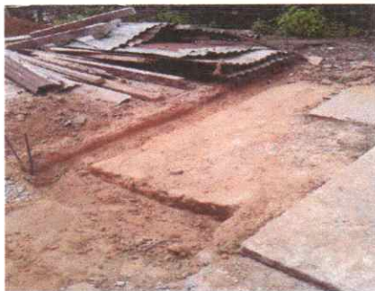
Foto 1: Lugar donde se trazó para la construcción de los mingitorios
