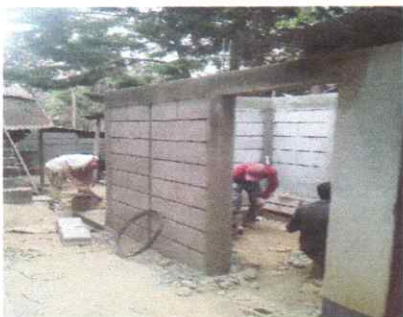
Foto 3: Construcción de los mingitorios y lavamanos
