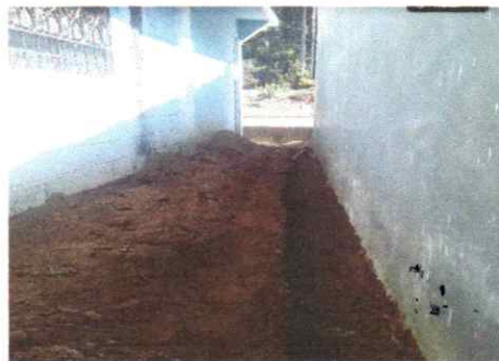
Foto 2: Apertura de la zanja para la construcción del muro perimetral
