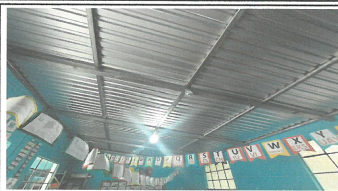
Vista de la estructura sustituida
