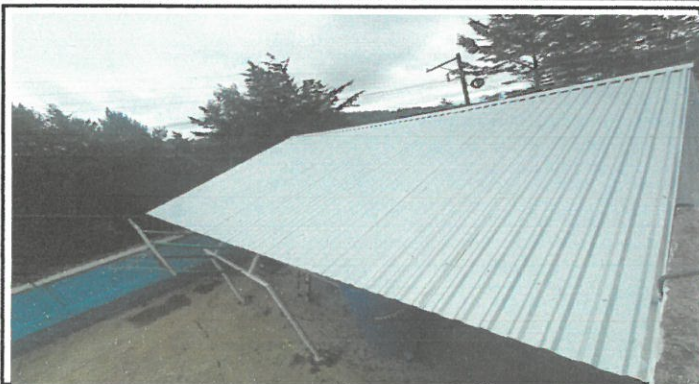
Vista del techo remozado
