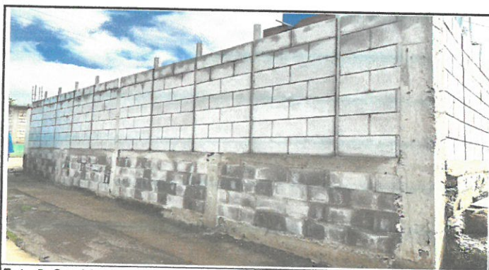
Foto 5: Cambio de muro de contención. Finalizado.
