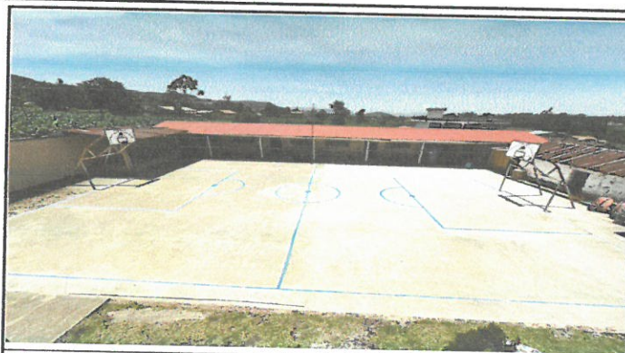
Foto 2: Pavimentación de cancha deportiva. Finalizado.
