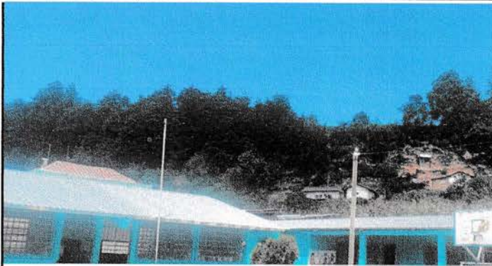
FOTO 1 . TERMINACIÓN DE TECHO
