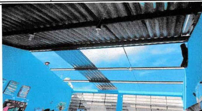
FOTO 1: CAMBIO DE TECHADO
