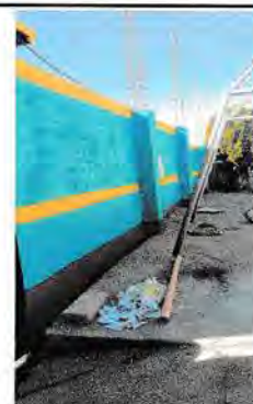
Foto 4: Colocación de columnas a muro perimetral.
