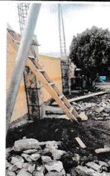
fotpo 2 colocacion de calumnas muro perimetral
