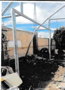
Foto 3: Pintada de muro y columnas.
