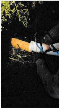
Foto 1: Sustrucion de tubos de drenaje
