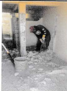
Foto 1: Sustitución de inodoros para niños y niñas.
