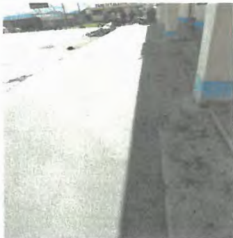
Foto 3: piso de concreto remozamiento
