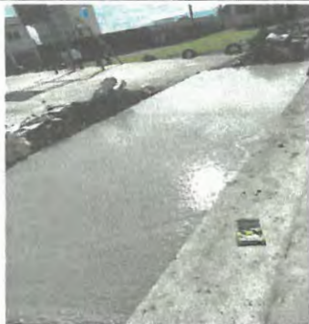
Foto 5: piso de concreto remozamiento
