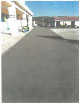
Foto 1: nuevo piso de concreto
