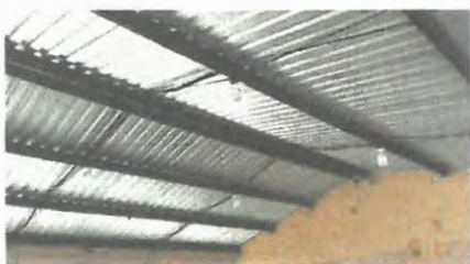
Foto 1: nuevo cableado para instalacion eléctrica
