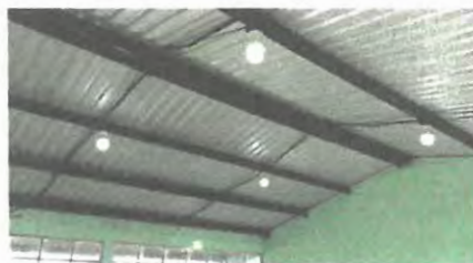
Foto 4: nuevo cableado de instalación eléctrica
