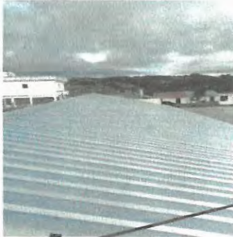
Foto 1: cubierta de lamina troquelada
