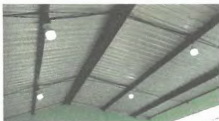
Foto 3: nuevo cableado de instalación eléctrica
