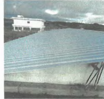
Foto 2: cubierta de lamina troquelada
