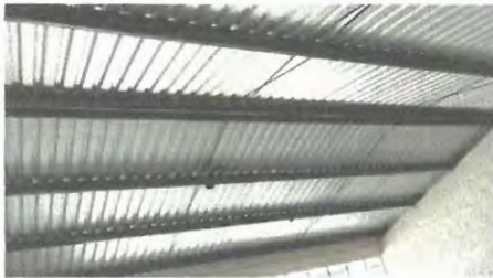
Foto 3: estructura pintada para lamina troquelada
