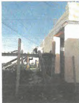
Foto 1: inicio de repello para impermeabilizar
