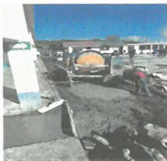
Foto 5: fundición piso concreto remozado
