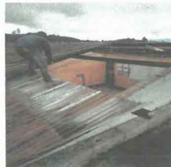
Foto 2: desmantelando aula No. 2 para su remozamiento
