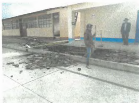
Foto 3: quitando piso deteriorado
