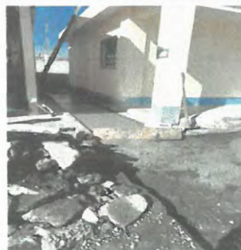
Foto 4: primera fundición piso concreto remozado
