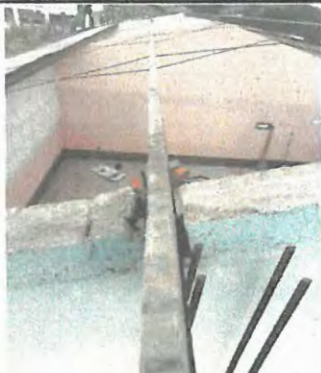
Foto 1: desmantelando aula No. 1 para su remozamiento
