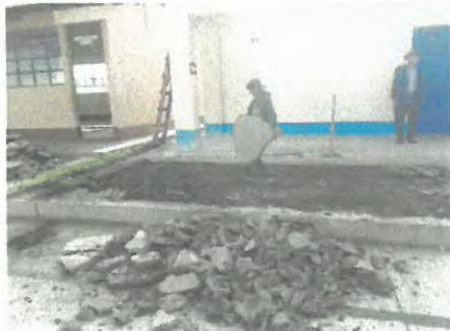
Foto 1: quitando piso deteriorado
