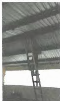
Foto 3: instalación del nuevo cableado eléctrico
