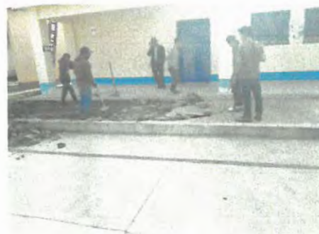
Foto 2: quitando piso deteriorado
