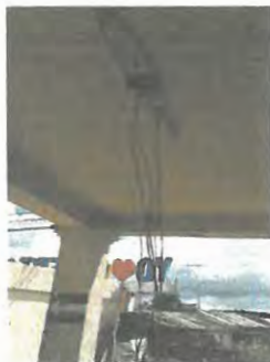
Foto 1: nuevo cableado para instalación eléctrica
