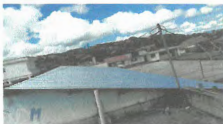
Foto 5: colocados de lamina troquelada.
