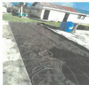
Foto 6: nivel del piso a remozar
