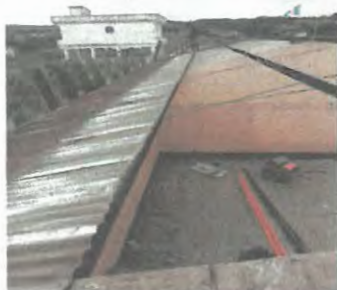
Foto 3: retirando lamina para su remozamiento
