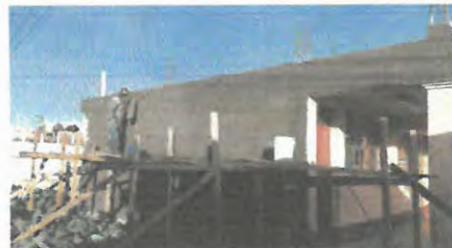
Foto 2: repello de impermeabilización
