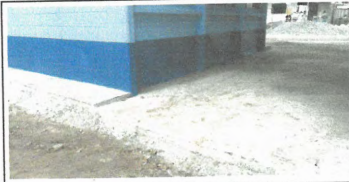
Foto 6: Banqueta de concreto remozada alrededor del aula No. 3.
