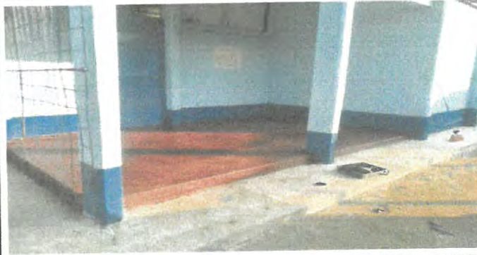
Foto 2: Reparación finalizado de pasillo con antideslizante de aula No.3.
