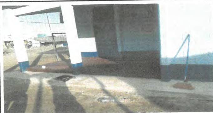
Foto 1: Reparación finalizado de pasillo con antideslizante de aula No.3.
