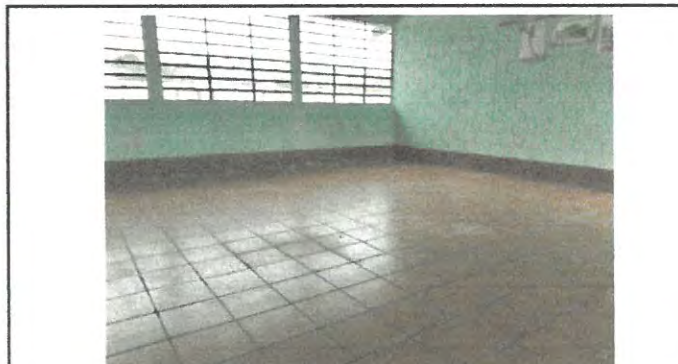
Foto 4: Colocación de piso cerámico finalizado del aula No. 1 de la escuela.
