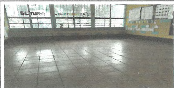
Foto 5: Finalizada la colocación de piso cerámico del aula No. 3 en relación a piso.
