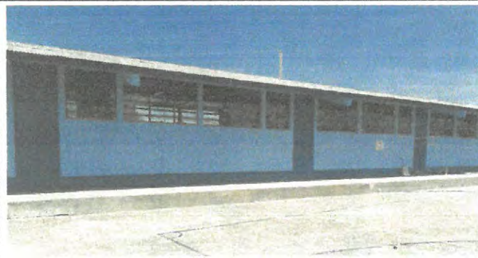
Foto 1: Pintada de paredes exteriores de aulas No. 1, 2, 3 y oficina de dirección.
