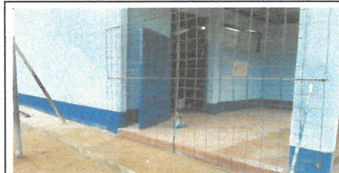
Foto 6: Electromalla colocada de protección entre aula No. 4 y cancha.
