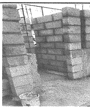
Foto 6: Servicios sanitarios en proceso de remozamiento
