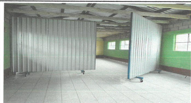
Foto 4: Cambio del interior de los ambientes a una división con rodos giratorios.
