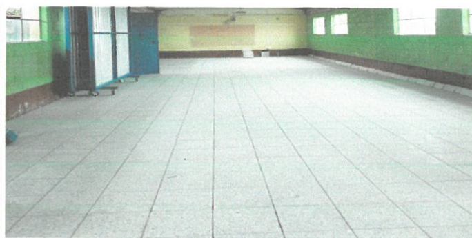
Foto1: Vista de cambio de piso rustico a piso de Granito
