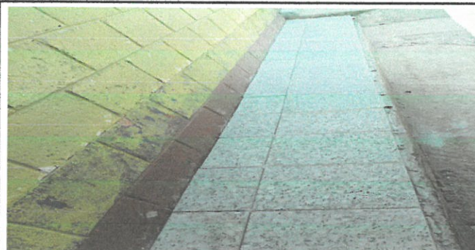
Foto 2: Vista de cambio de piso rustico a piso de Granito en la parte exterior del modulo.
