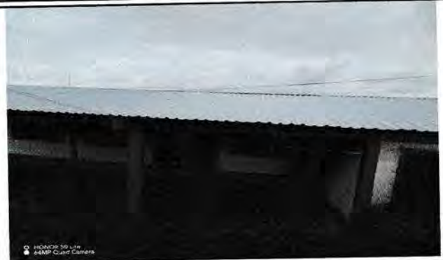
Foto 2: Techo de Módulo 2
