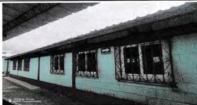
Foto 5: Ventanas y balcones
