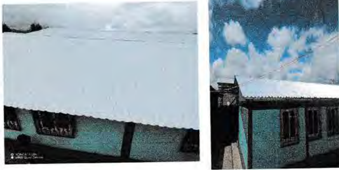
Foto 1: Techo de Módulo 1
