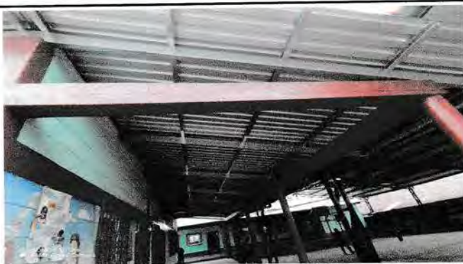
Foto 3: Cambio de Costaneras de módulo 1.
