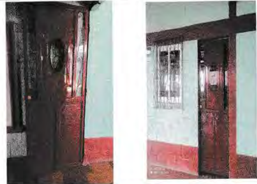
Foto 4: Puertas de aulas y Dirección
