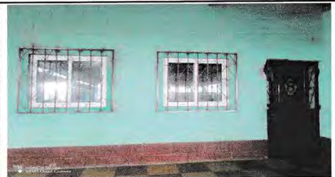
Foto 6: Ventanas, puertas y balcones.
