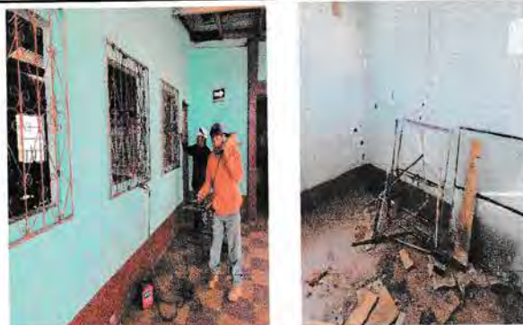
Foto 4: Mantenimiento de balcones y cambio de ventanas
