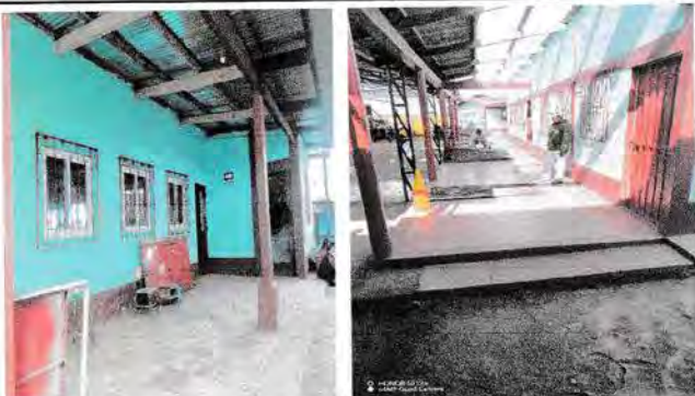
Foto 3: Cambio de puertas
