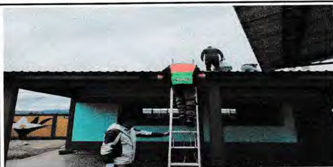
Foto: Cambio de Techo módulo 2
