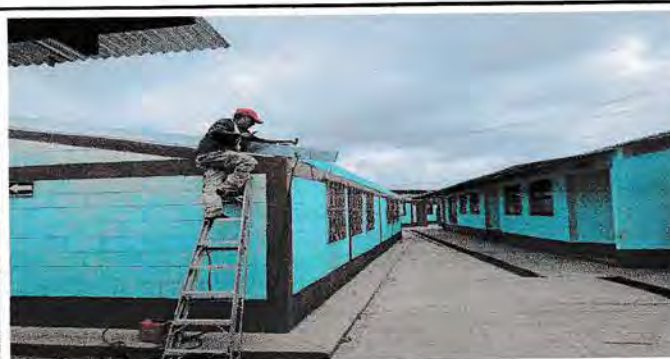
Foto 6: Cambio de costaneras y techo módulo 1
