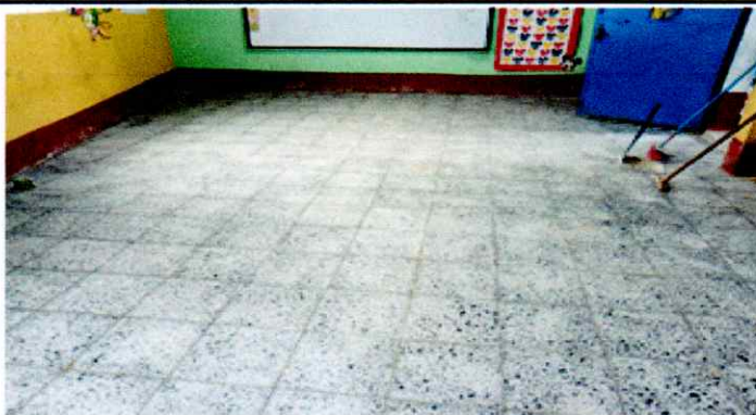
Foto 2: finalización de colocación de piso ceramico
