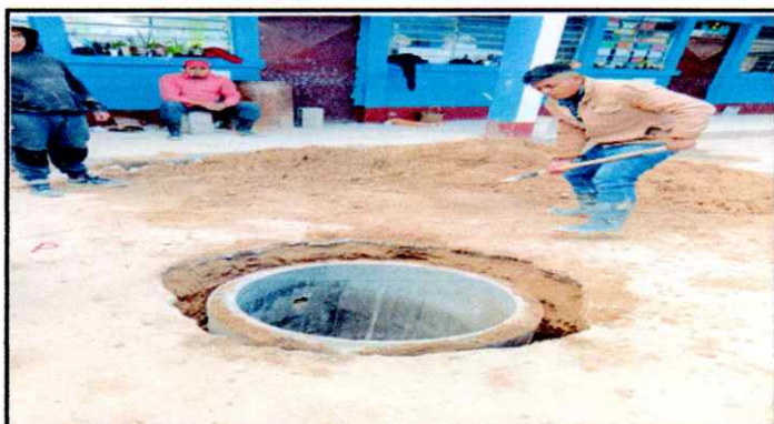
Foto 4: finalización Ampliación de fosa septica
