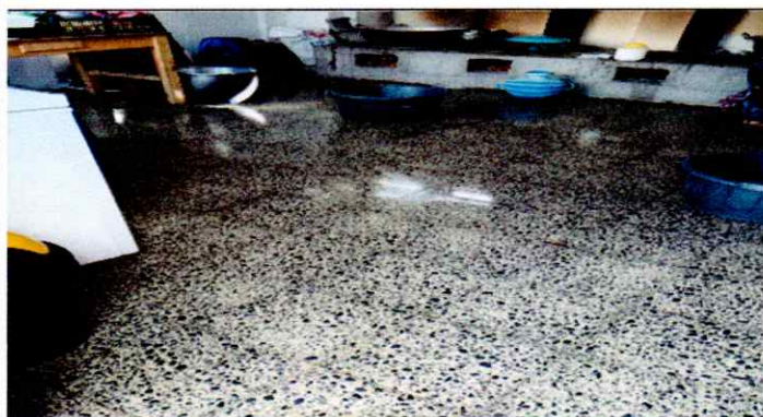
Foto 3: finalización de colocación de piso de granito en cocina
