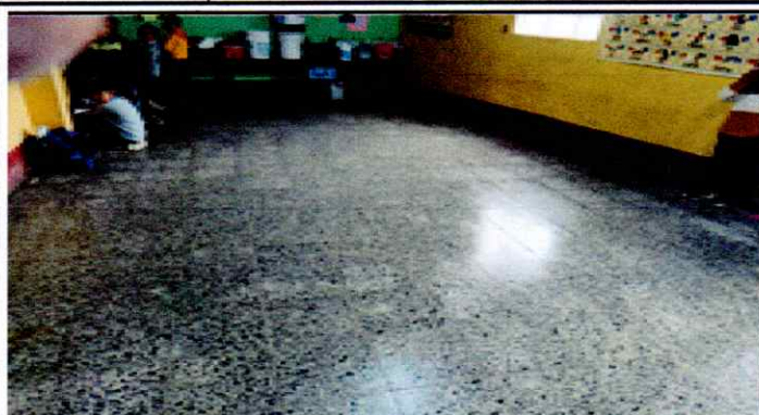
Foto1: Finalización de colocación de piso ceramico
