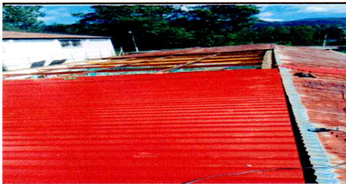
Foto 5: Sustitución de lamina Troquelada
