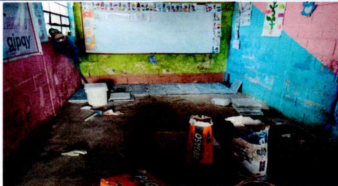
Foto1: colocación de piso ceramico
