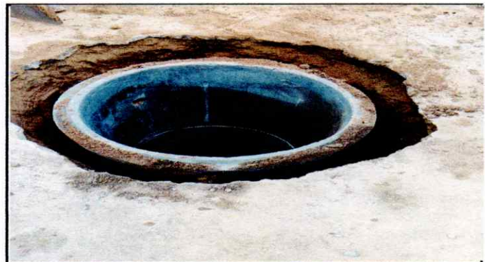
Foto 4: Ampliación de fosa septica
