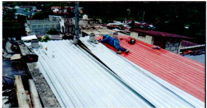
Foto 6: sustittución de lamina troquelada
