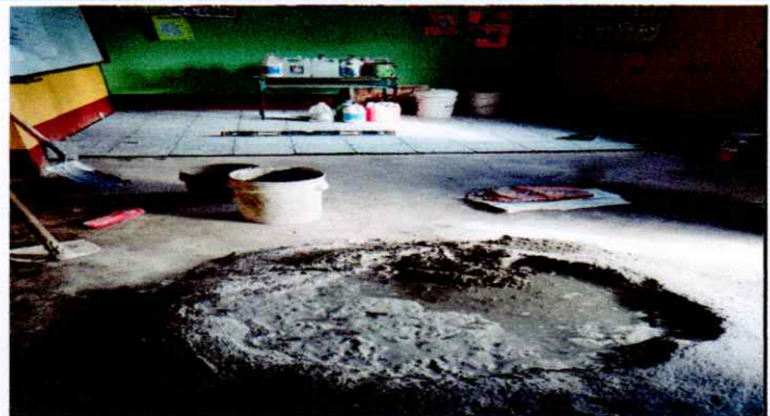
Foto 2: colocación de piso ceramico
