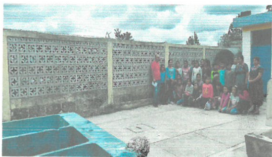
Foto 5: Cerco perimetral en parte posterior del establecimiento
