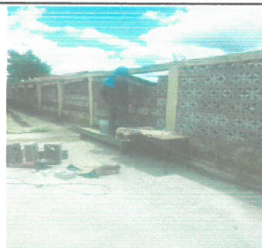
Foto 6: Cerco perimetral en parte posterior del establecimiento
