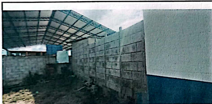
Foto 3: Muro perimetral de blockon
