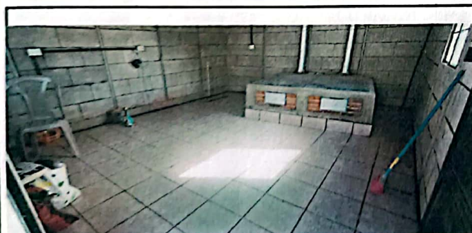
Foto 5: Cerámico y conexión eléctrica de la cocina
