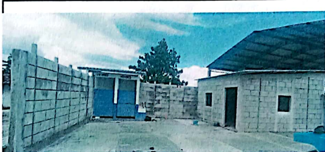
Foto 2: Pavimento de patio culminado
