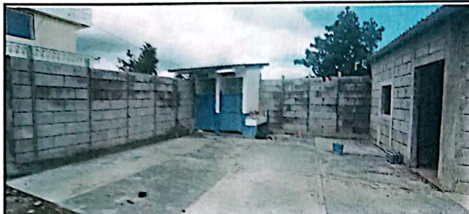
Foto 1: Muro perietra de blockon culminado
