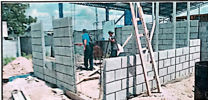
Foto 3: Proceso de colocación del blockon de las paredes de la cocina
