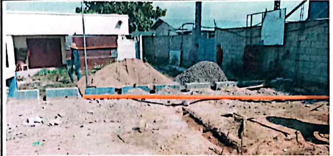
Foto 2: Zanajas para el cimiento de la cocina
