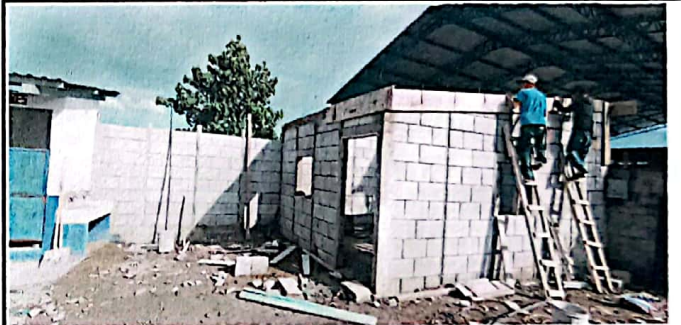
Foto 4: Colocoación del blockon en paredes, muro perimetral y coración de la cocina
