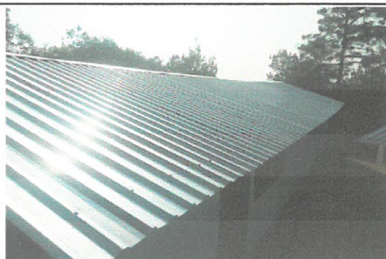
Foto 2: cambio de lamina
