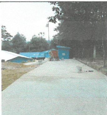
Foto 1: área para pavimentar
