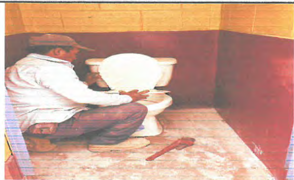
Foto1: Vista frontal colocación de la taza
