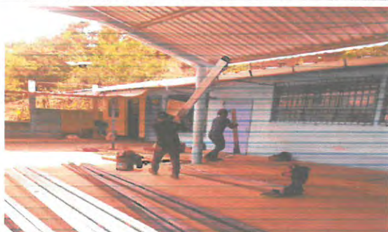
Foto 3: Vista frontal colocación de estructuras metálicas.
