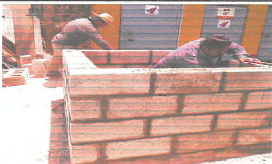
Foto 5: Vista reconstrucción pozo ciego
