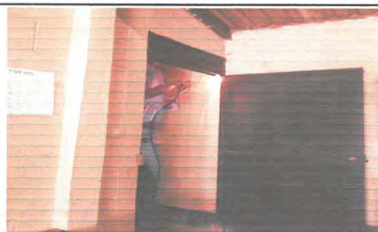
Foto 6: Vista de reajuste e instalación de la puerta.
