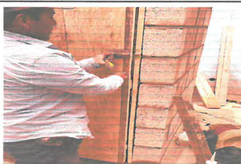
Foto 6: Vista colocación puerta pozo ciego.
