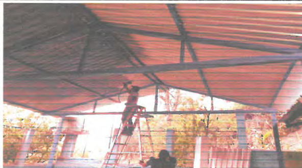
Foto 4: Vista frontal pintando las láminas.
