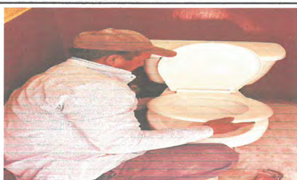
Foto 2: Vista frontal de la colocación de la taza
