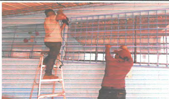
Foto 3: Vista frontal de la instalación de balcones.
