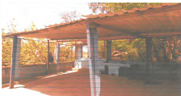
Foto 1: Vista frontal de la estructura de madera por estructura de metal y lámina troquelada.
