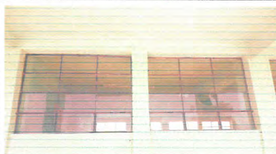
Foto 6: Vista frontal de las ventanas a reparar
