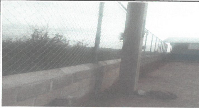
Foto 1: Vista de la terminación del cerco perimetral
