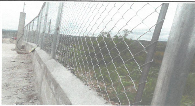
Foto 3: Terminación del cerco perimetral
