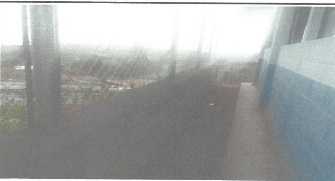
Foto 5: Culminación del cerco perimetral de la Escuela
