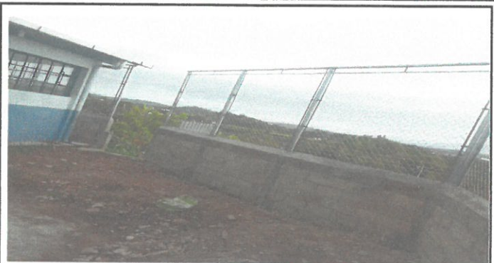
Foto 2: Terminación de cerco perimetral de la Escuela con block, maya y tubos galvanizados
