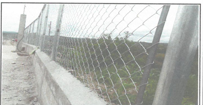
Foto 6: Terminación del cerco perimetral de block, columnas de por medio, tubos galvanizados y maya de 80 mts. Lineales
